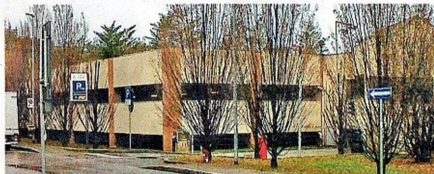
L'ingresso del parcheggio multipiano 'Silos' di via De Gasperi
